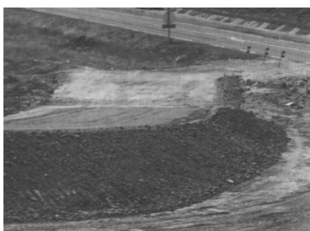
Angle critique du tas de sable observé sur un remblai d'autoroute en construction
